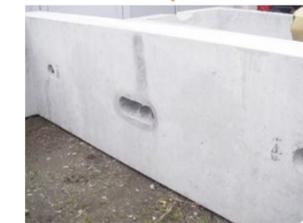
側壁部 吊金具用孔
