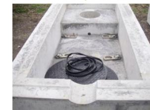
吊金具設置状況 2t用カプラ取付
