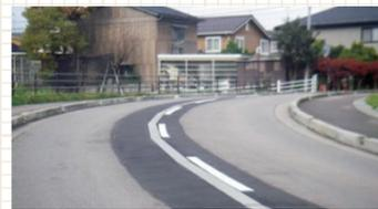
プレキャストコンクリートとは工場であらかじめ組み立て一体化された製品のことをいいます。消雪ブロックはパイプ・ノズルをブロックに内蔵した工場製品です。
